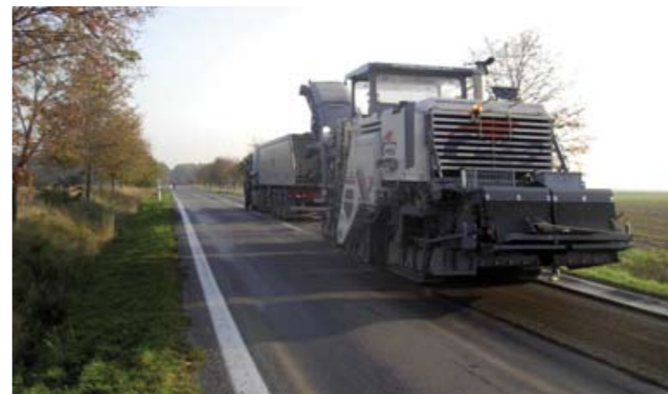
Stroj 2200CR při práci jako vysoce výkonný stroj pro frézování za studena.
