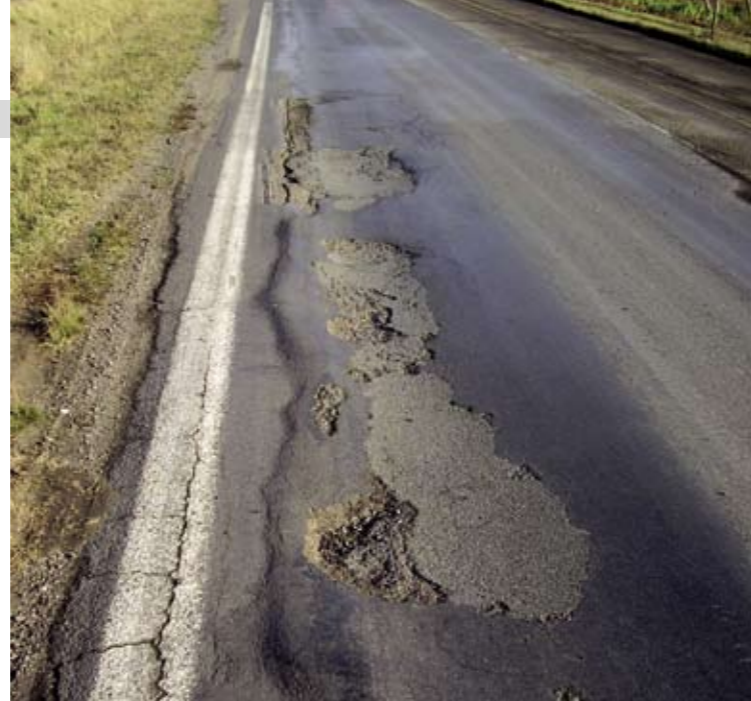
Povrchová vrstva této silnice byla pokryta sítí prasklin a prohlubní, které jasně indikují, že podkladní vrstva byla poškozena.
