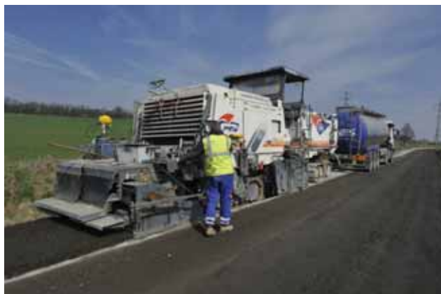
Recyklér za studena 2200CR vybavený vstříkovacím systémem pro vodu a vstříkovacím systémem pro asfaltovou emulzi, rozdělovacím šnekem a pokládací lištou.
